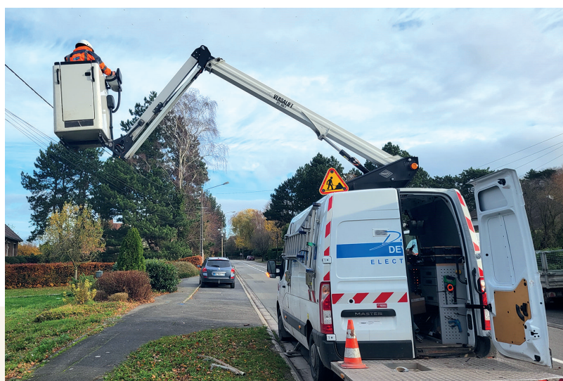
Rénovation de l'éclairage rue de Roucourt
