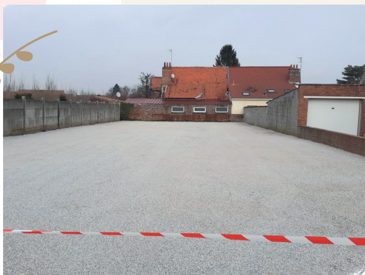
Création d'un parking rue des Peupliers
