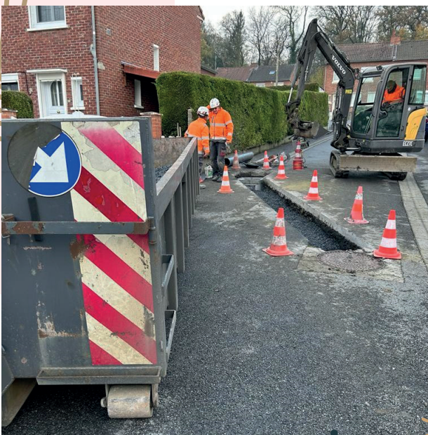
Rejet des eaux de pluie cité Bandini et rue de Monchecourt
