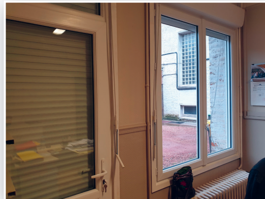
Isolation des bureaux de la mairie
