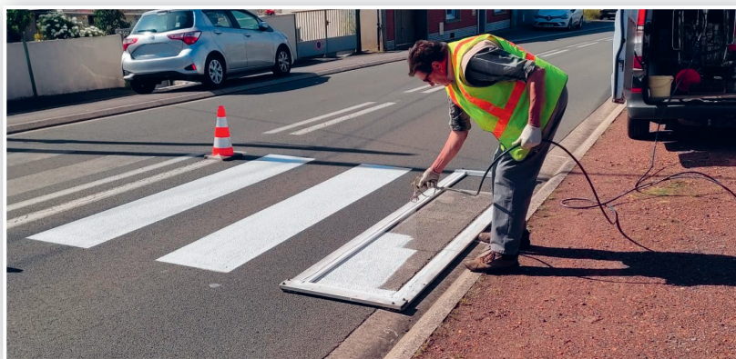
Marquage de la chaussée
