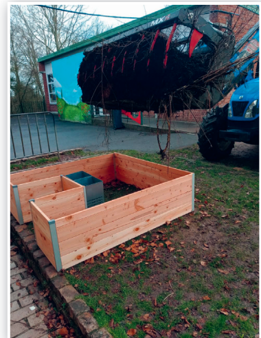
Installation d'un potager à l'école élémentaire avec l'aide des services techniques
