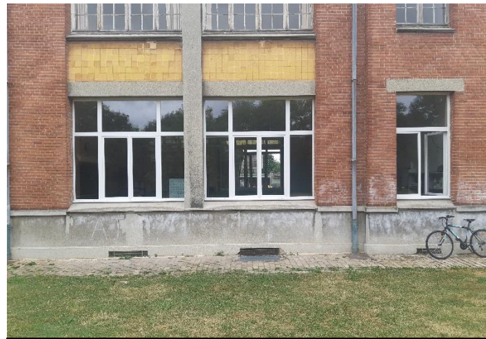
Réfection totale des menuiseries des écoles
