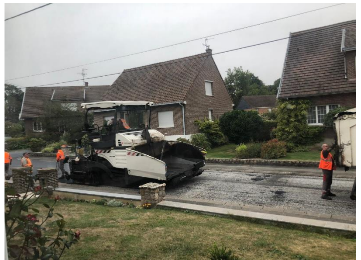
Réfection de la rue Saint Rémy
