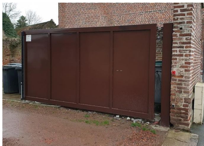
Installation d'un nouveau portail d'entrée aux services techniques
