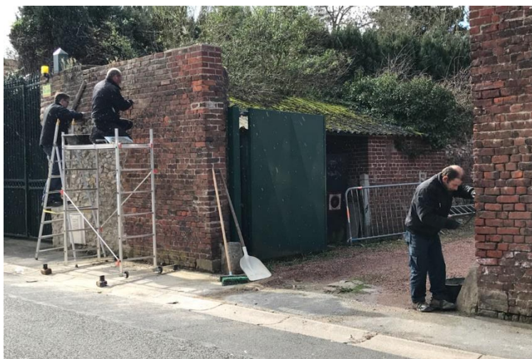
Réfection de la façade de la salle de javelots, rue d'Erchin
