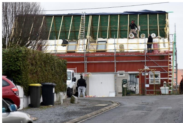
Isolation des maisons du castel par Norévie
