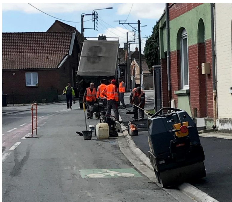
Rénovation des conduites d'adduction d'eau de la rue de Loffre par Noréade
