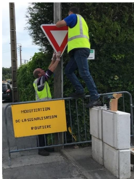
Modification de la signalisation routière pour plus de sécurité rue de Loffre
